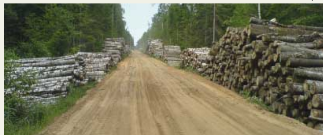
Построенная лесохозяйственная дорога и ее использование
